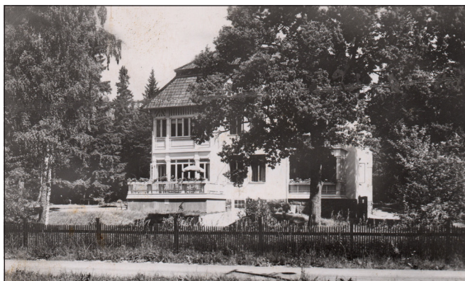
Fröken Westmans pensionat i Södertörns Villastad.
