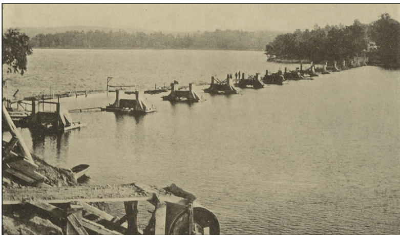
"PELARNA UNDER ARBETE • SIDOVY"
